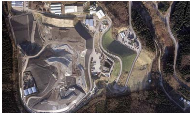
Luftbild vom Leppe-Deponiegelände im Jahr 2009.
